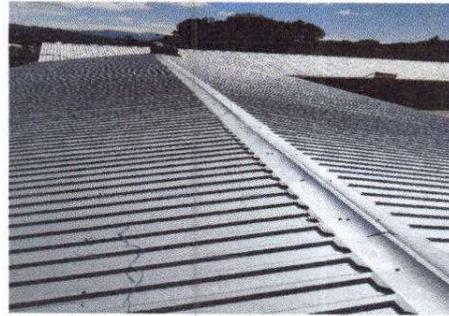
Foto 2: Sustitución de capotes para lamina troquelada.
